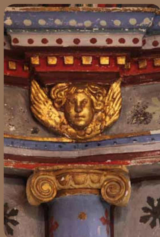
Détail de l'ossature en bois peint © Club photo du Pays d'Olmes
