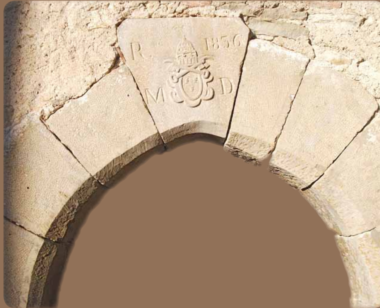
Clé de voûte et pierres bouchardées, porche de l'église © Pays des Pyrénées Cathares
