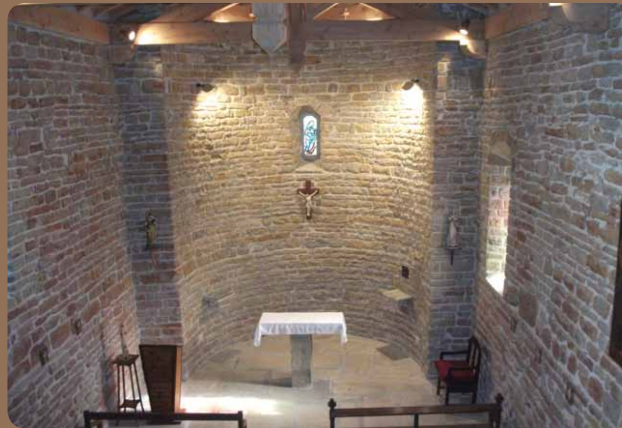
Abside plus étroite que la nef et fenêtre axiale, église Saint-Sernin du Villaret © Club photo du Pays d'Olmes
